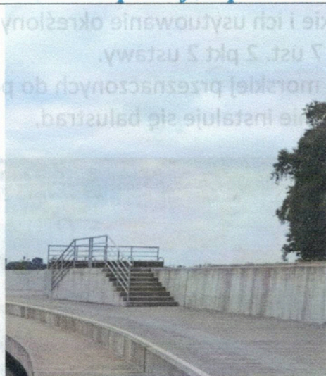
Rys 1. Widok na murek oporowy
