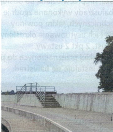
Rys 1. Widok na murek oporowy
