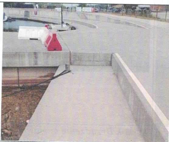
Rys 7. Obniżenie poziomu naziomu nabrzeża o 30 cm
